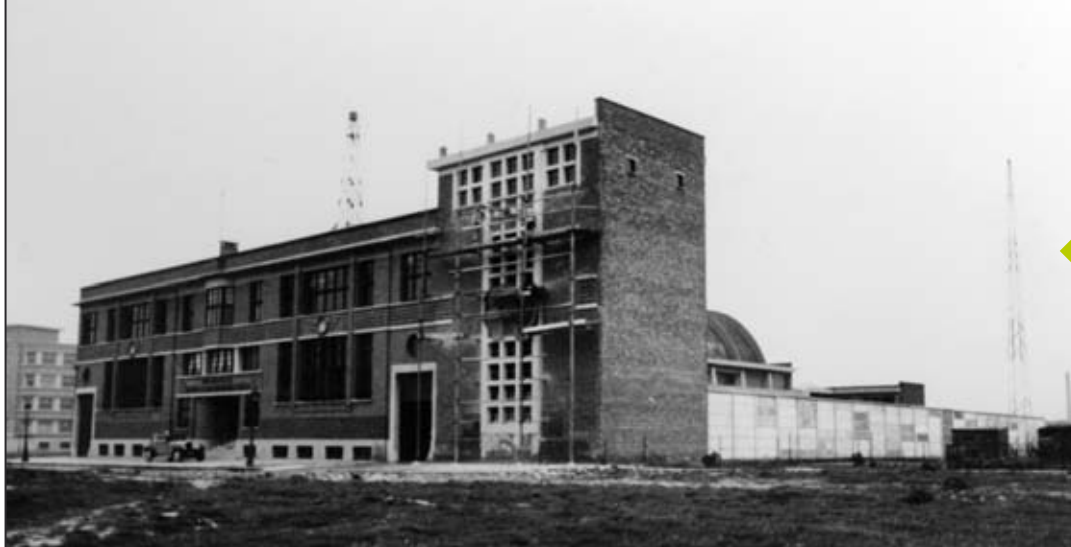
Institut de Mécanique des Fluides de Lille en Construction (1929).
