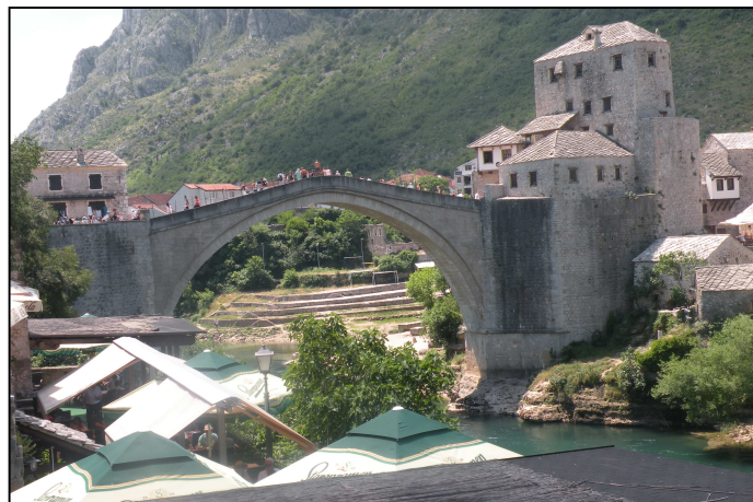
Le pont de Mostar
